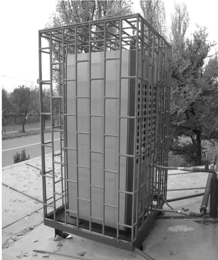
**Рис. 3. Тепловий насос IVT Optima 1700.**
