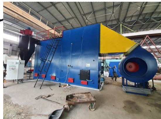
Рис. 1. Високоєфективна електрогенеруюча установка на основі використання несертифікованого біопалива з сільськогосподарських відходів
