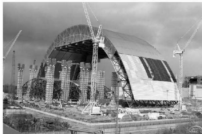
Рис. 10. Схема Объекта «Укрытие» и Нового Безопасного Конфайнмента в поперечном сечении (а) и фото частично собранного НБК (октябрь 2014 г.) (б: 1 – машзал, 2 – разрушенный реактор, 3 – Объект «Укрытие», 4 – основной объем НБК, 5 – стальные конструкции и кольцевое пространство Арки НБК.
