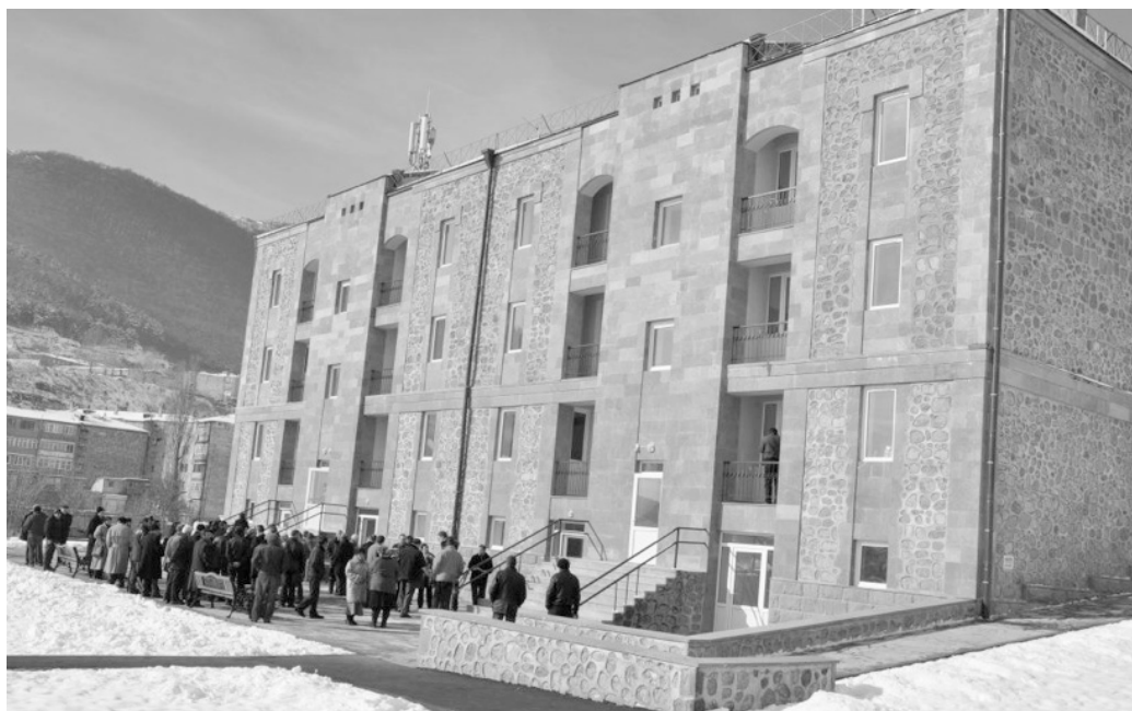
Рис. 5. Энергоэффективный жилой дом в г. Горис (Армения) [16].
