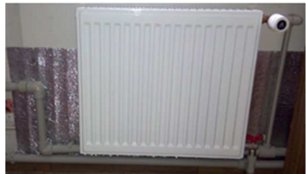
Рис. 5. Фрагмент нового нагрівального приладу і регулятора температури "Danfoss"
