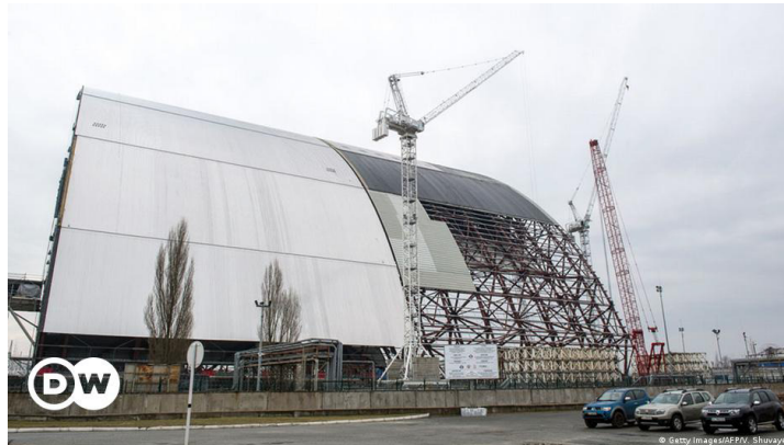
Рис. 1. Зовнішня оболонка НБК ЧАЕС на стадії будівництва [1]
