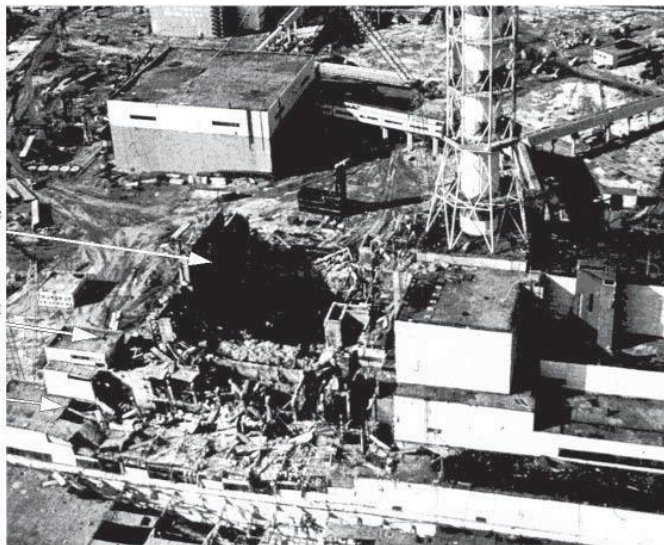
Рис. 1. Разрушенный 4-ый блок ЧАЭС (май 1986 г.).
